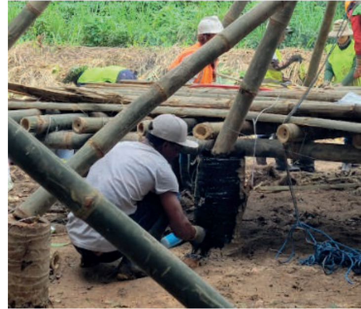
3 Cimentación Tipo III (2cañas contrapuestas distintas direcciones)
